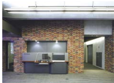
自動書庫ステーション（B1F～3F） 自動書庫（B2F）の資料はB1F～3Fの全てのフロアに搬送可能です。
